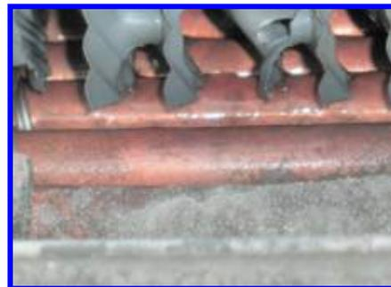
薬品カット、ブロー水カットにも関わらず、銅管、充填剤のスケールが軟溶化して剥離が進んでいる。
